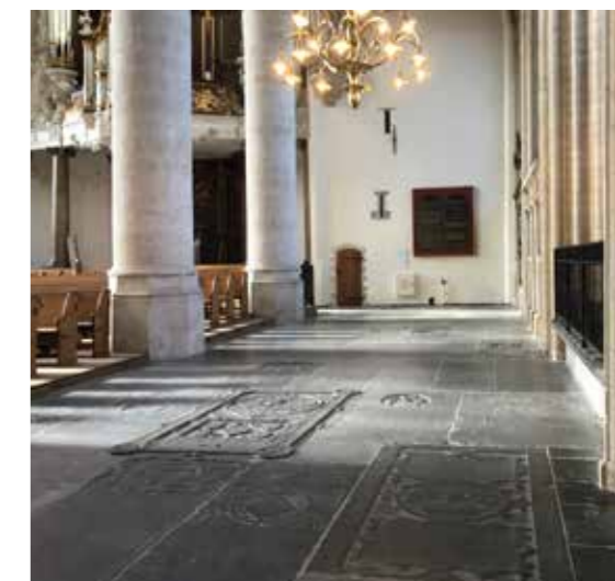
De fraai gerestaureerde vloer in het zijschip
