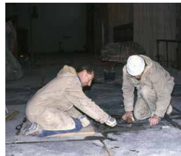
Het voegen van de naden tussen de grafzerken
