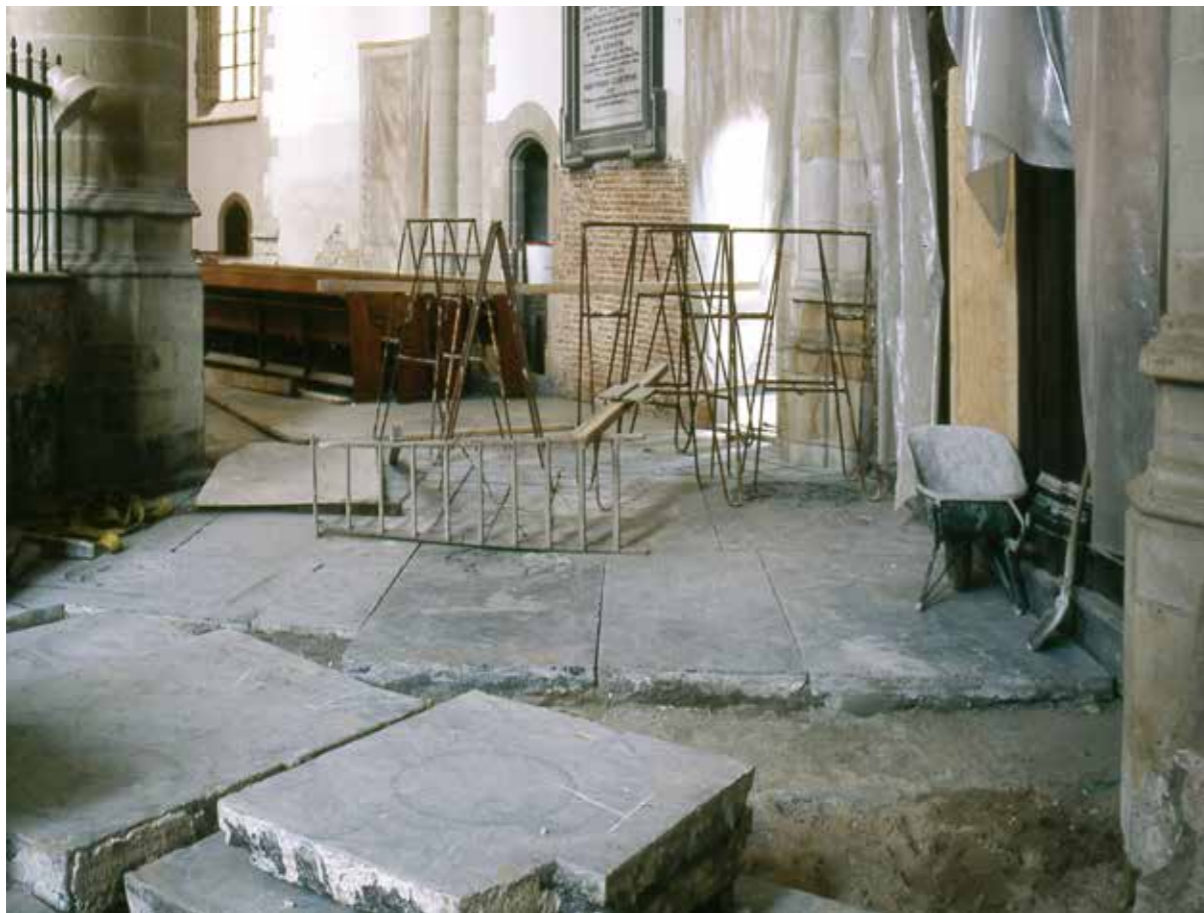
Het egaliseren van de vloer tijdens de restauratie van 1984-1987
