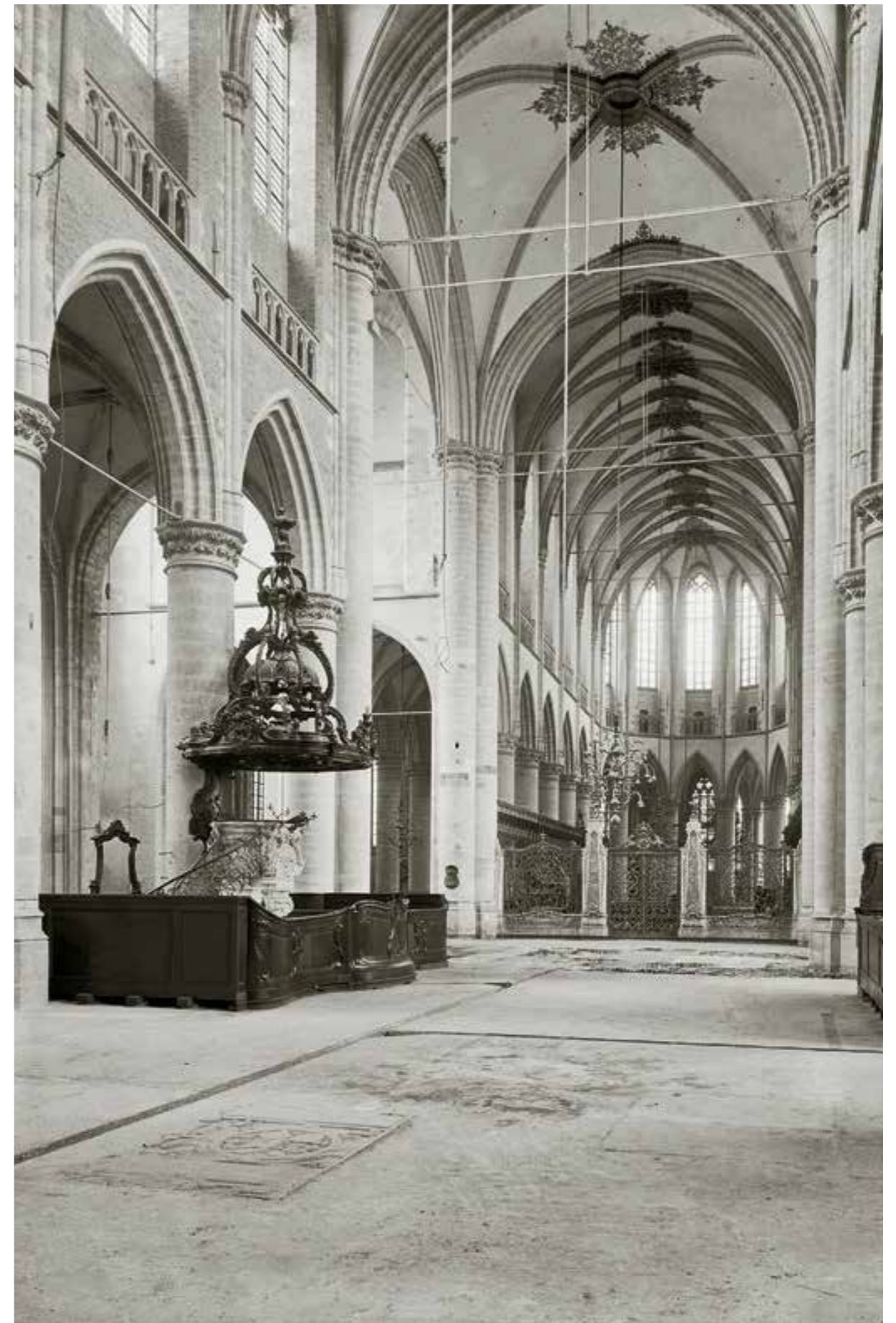
De aanleg van de betonnen vloer. Op een houten ondergrond zouden de banken worden geplaatst
